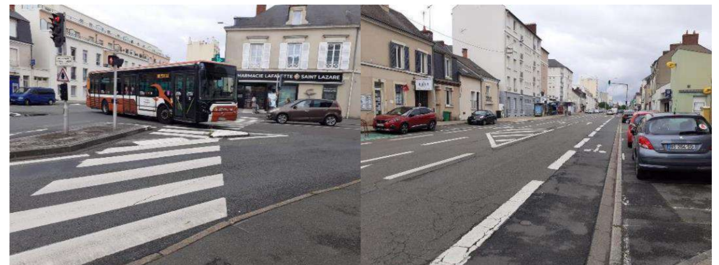
Figure 188 : Photographies de l'Avenue de la Libération – SERUE Ingénierie
