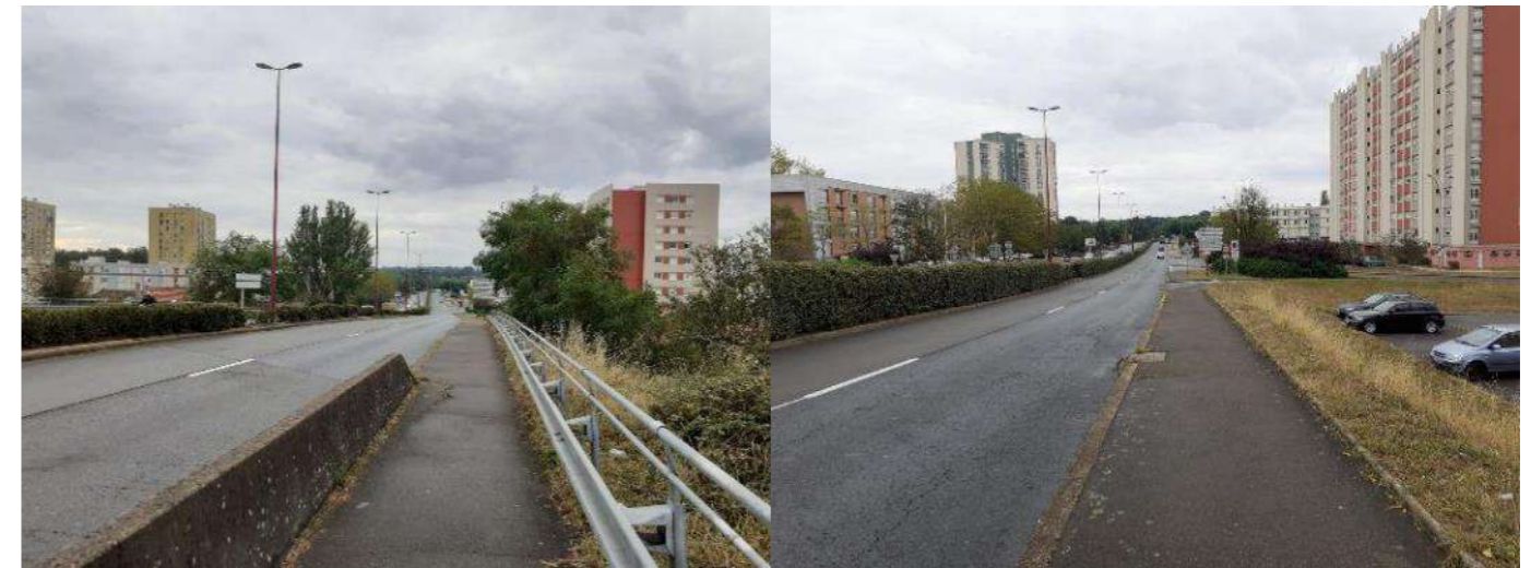
Figure 213 : Photographies du Boulevard Cugnot – SERUE Ingénierie
