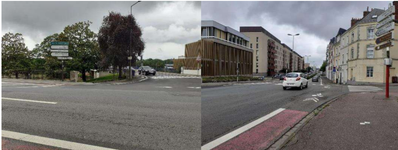
Figure 190 : Photographies du boulevard Demorieux (gauche) et Paul Courboulay (droite) – SERUE Ingénierie
