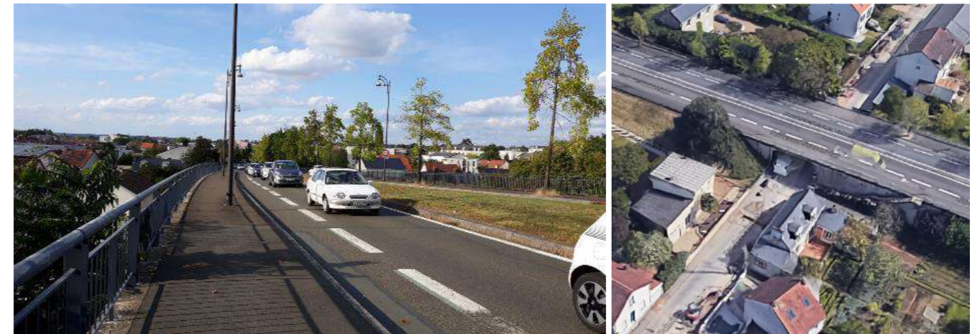
Figure 227 : Photographie de l'ouvrage d'art sur le boulevard Saint-Michel – SERUE Ingénierie (gauche), EGIS (droite)
