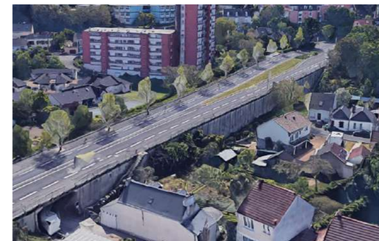
Figure 228 : Photographie de l'ouvrage existant
