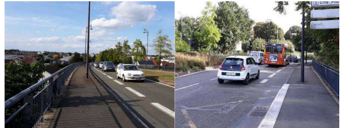
Figure 195 : Photographies du boulevard Saint-Michel – SERUE Ingénierie
