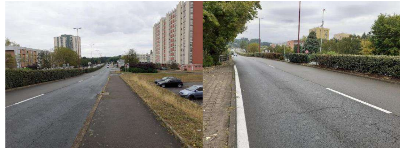
Figure 209 : Photographies du Boulevard Cugnot (première section) – SERUE Ingénierie
