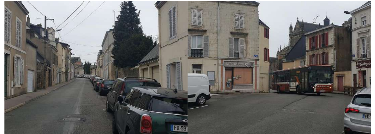
Figure 199 : Photographies de la rue Henry Delagenière – EGIS
