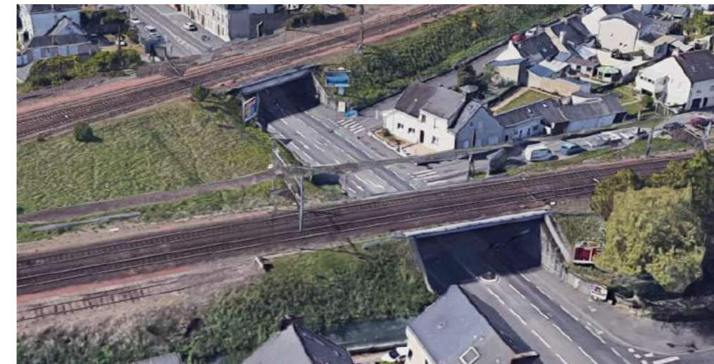
Figure 232 : Photographie de l'Avenue Olivier Heuzé et du franchissement des voies SNCF – EGIS
