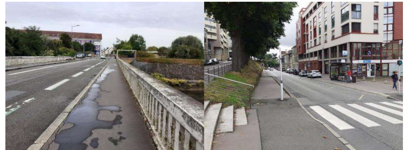
Figure 191 : Photographies du pont des Tabacs (gauche) et de la rue Barbier (droite) – SERUE Ingénierie
