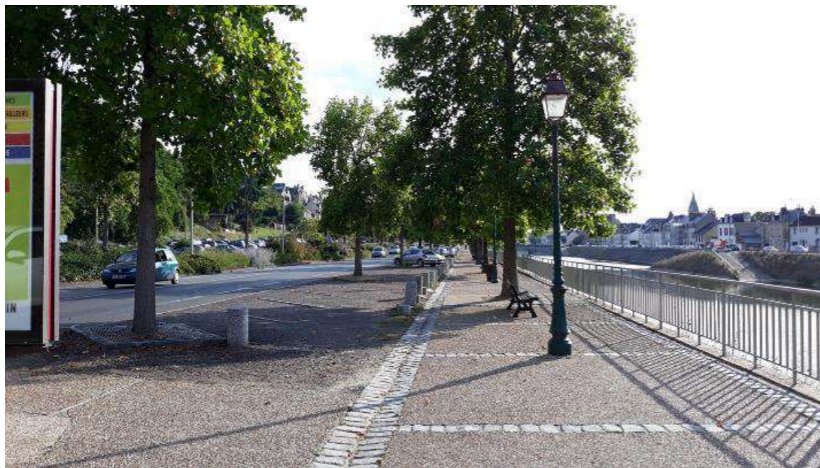
Figure 137 : Vue de la Sarthe depuis le Quai Louis Blanc – SERUE Ingénierie
