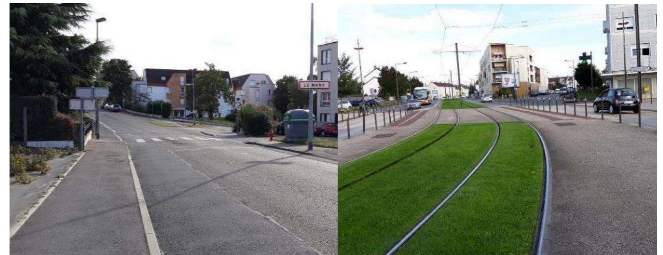
Figure 196 : Photographies du secteur de Coulaines – SERUE Ingénierie
