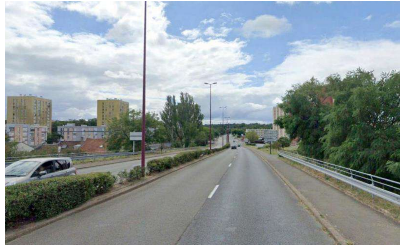
Figure 36 : Boulevard Cugnot existant - vers Sablons
