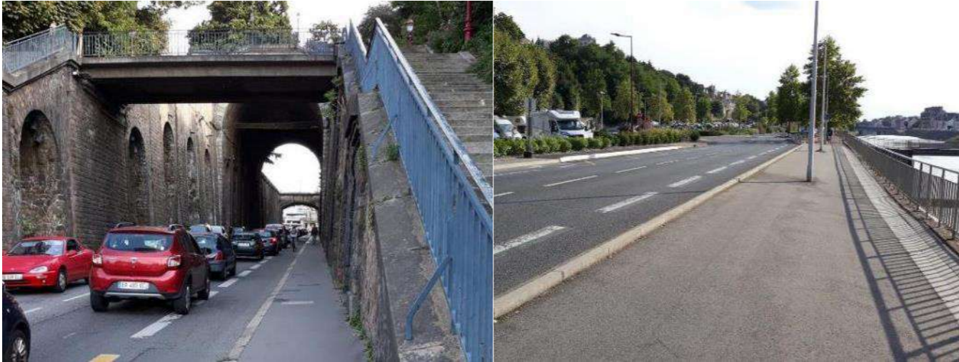
Figure 193 : Photographies de la rue Wilbur Wright (droite) et le quai Louis Blanc (gauche) – SERUE Ingénierie
