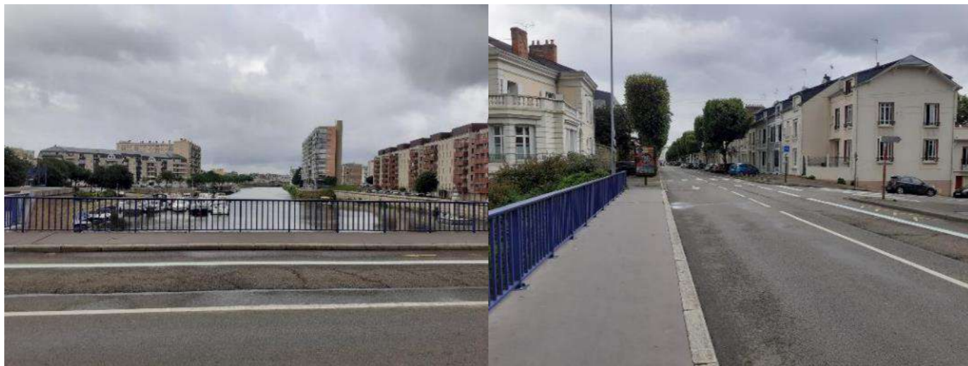
Figure 230 : Photographie du pont du Greffier – SERUE Ingénierie
