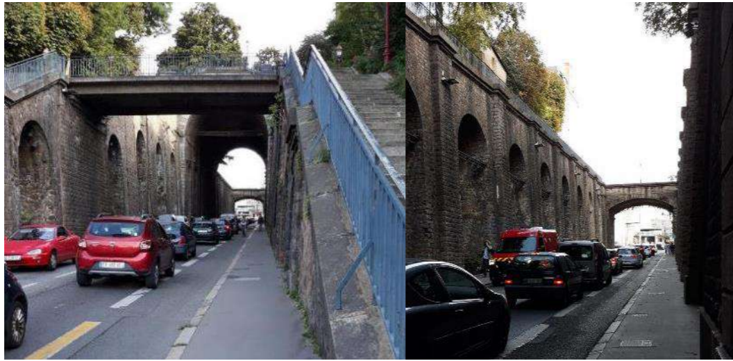
Figure 229 : Photographie de du pont de la rue Wilbur Wright – SERUE Ingénierie
