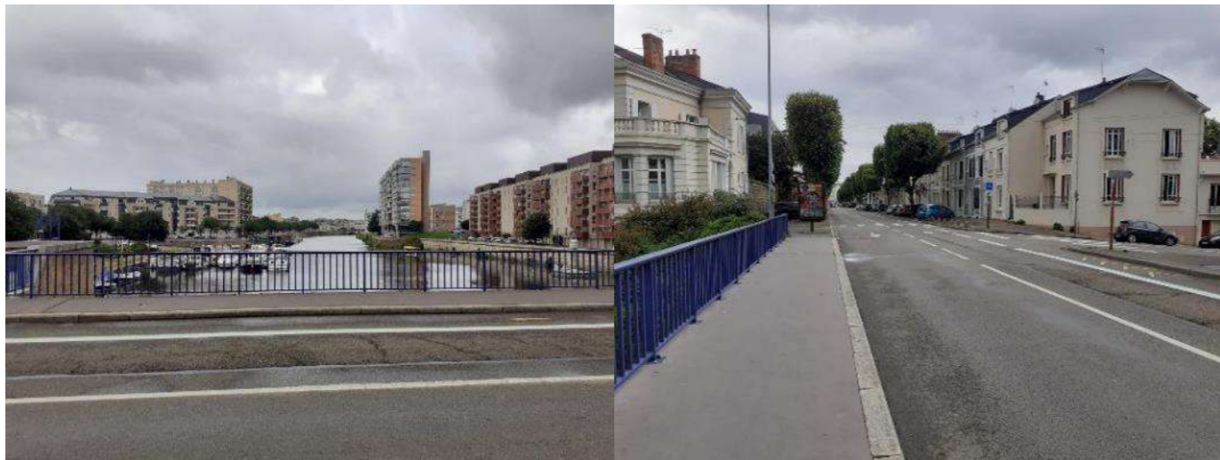
Figure 198 : Photographies du Boulevard Anatole France – SERUE Ingénierie
