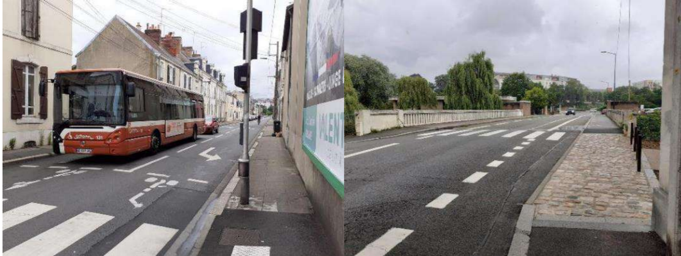
Figure 189 : Photographies de la rue d'Eichthal (gauche) et du pont d'Eichthal (droite) – SERUE Ingénierie
