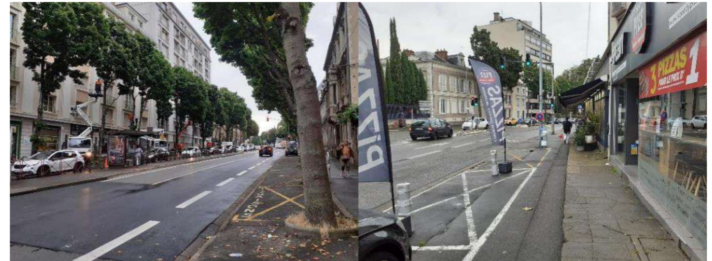
Figure 216 : Photographies de l'Avenue Bollée Nord – SERUE Ingénierie
